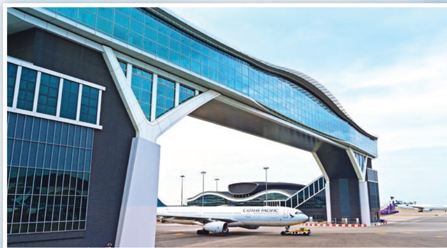
Spanning a taxiway at HKIA, the 28-metre high Sky Bridge allows aircraft to smoothly pass under it. 天際走廊高達28米，橫跨香港國際機場的滑行道，可讓飛機輕易地從下方通過。
