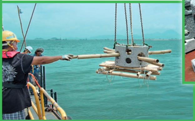
Lifting the AR units for the pilot study. 工人正吊運先導計劃採用的人工魚礁。
